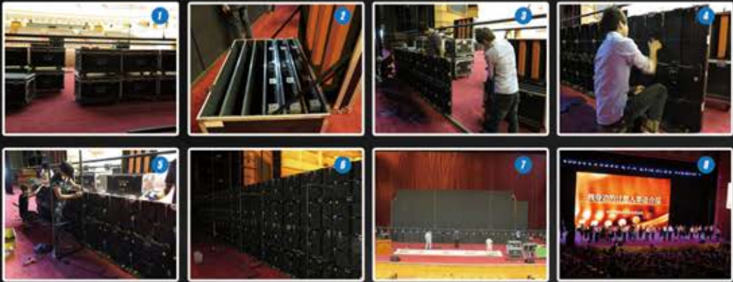
LED高清大屏实地安装步骤图解
